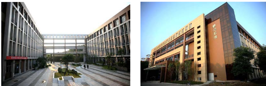
图5 学校李渡校区综合教学楼全面投入使用
